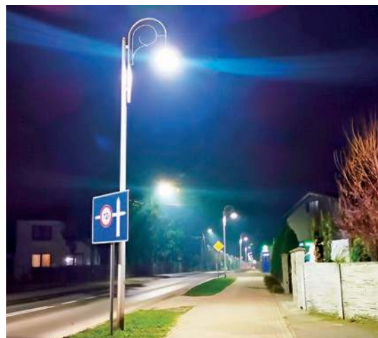
Wymieniono 83 oprawy lamp na energooszczędne
