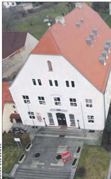
Budynek SOSW w Głogówku
