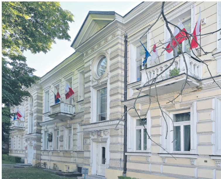
Budynek prosi się o remont.
