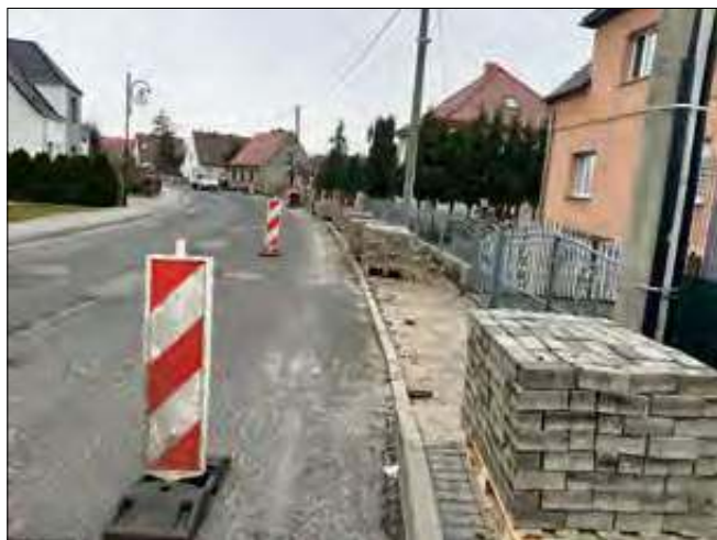
Prace już trwają.
