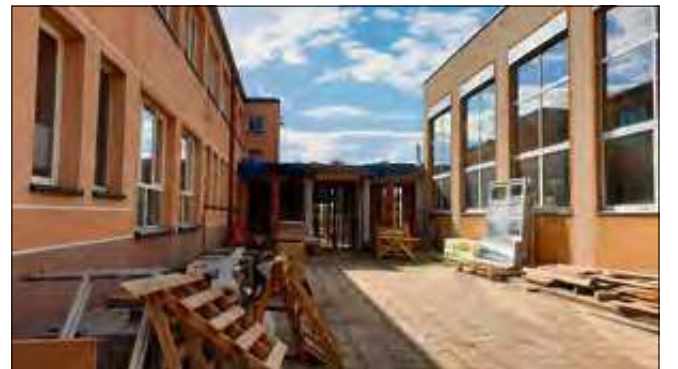
Po przebudowie uczniowie będą mogli chodzić na wf bez opuszczania budynku.
