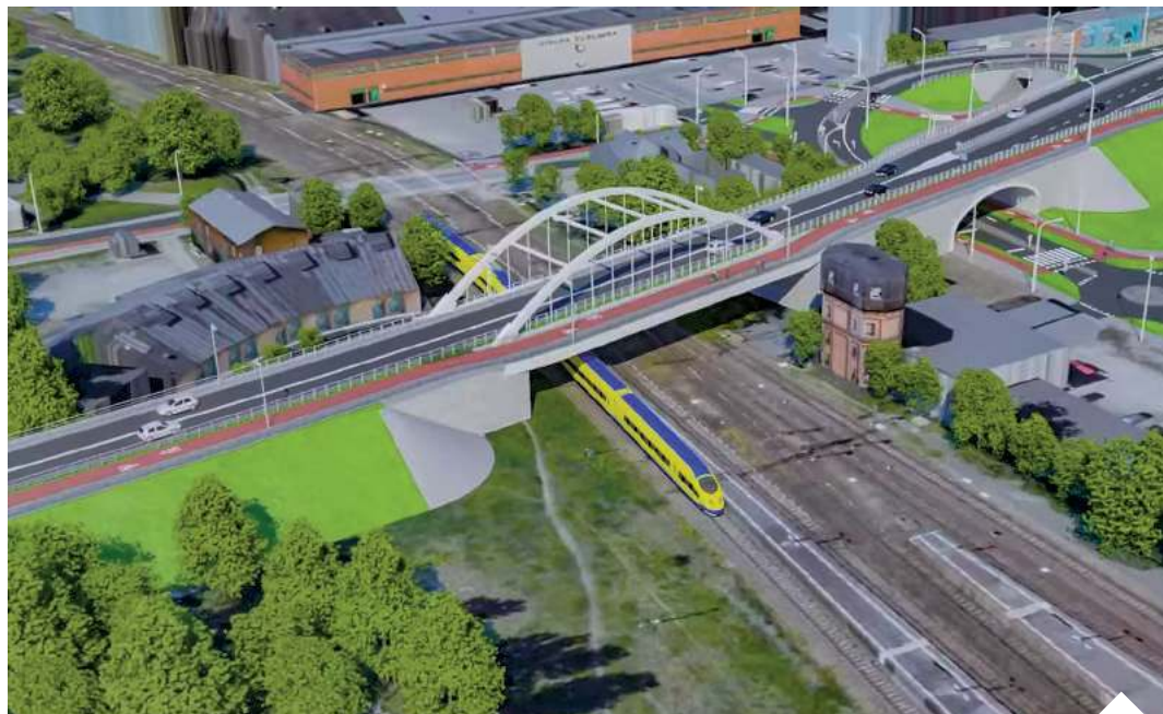
Elbląski wiadukt grozi katastrofą budowlaną | fot. YouTube/d
