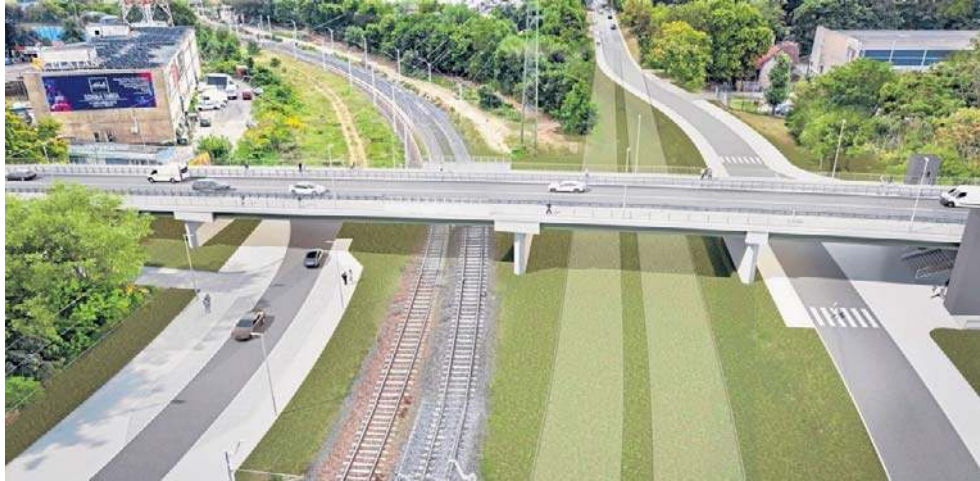
Wiadukt na ul. Jagiellońskiej nad linią do Polic i ul. Twardowskiego. Widoczna jest również droga wewnętrzna od strony ul. Jagiellońskiej
