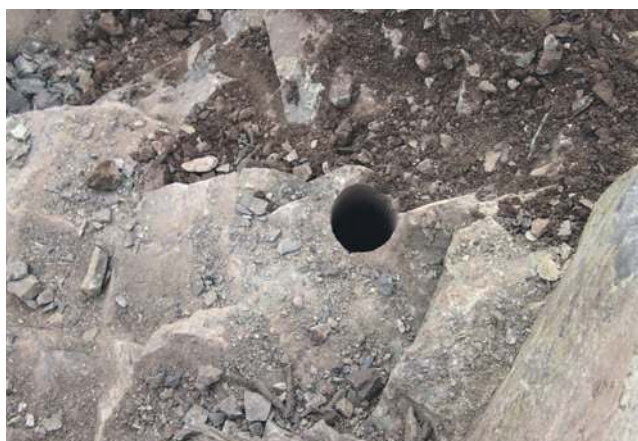
Odwiert na ładunek wybuchowy
