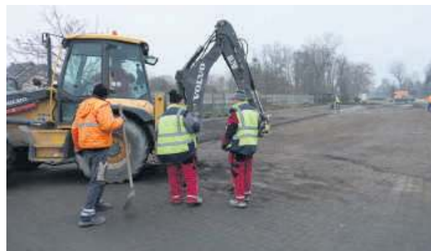
Terenu i Roboty Bitumiczne. Jarząbek” z Brzegu.
