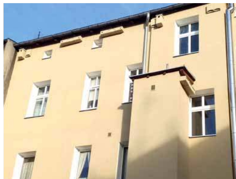
TBS przeprowadzając renowację stargardzkich kamienic nie zapomina o montowaniu budek lęgowych dla ptaków
