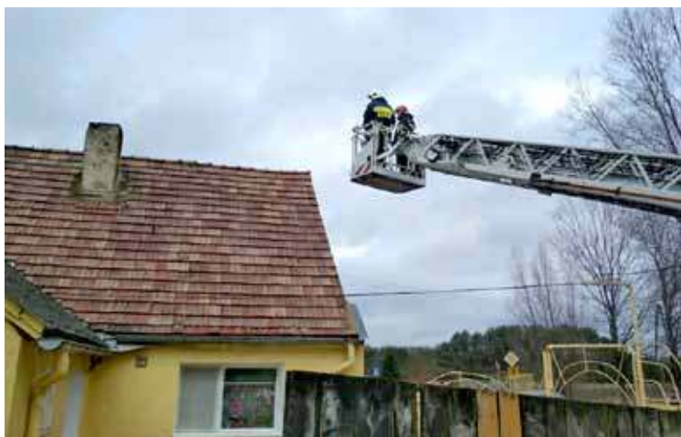
28 grudnia strażacy gasili pożar przewodu kominowego w miejscowości Sulino. Foto. OSP. Marianowo.
