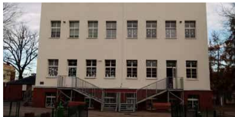
Zakończyła się termomodernizacja SP 3. Elewacja budynku teraz ma kolor kawy z mlekiem.jpg
