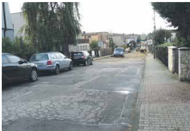
Mieszkańcy chcą, by nowy asfalt był na całej ulicy, do skrzyżowania z ul. Opatowicką
