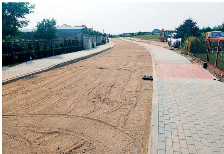
Tutaj, od poniedziałku, jest już położony asfalt
