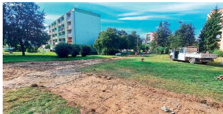
W miejsce wydeptanych ścieżek powstaną chodniki
