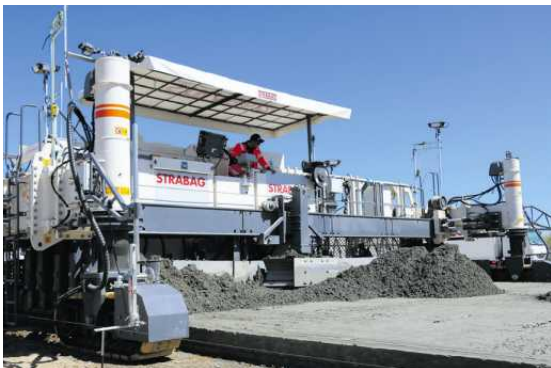
Niskoemisyjny cement zastosowany do budowy dróg.
