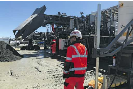
STRABAG zastosował niskoemisyjny beton do budowy nawierzchni autostrady A2 pod Siedlcami.
