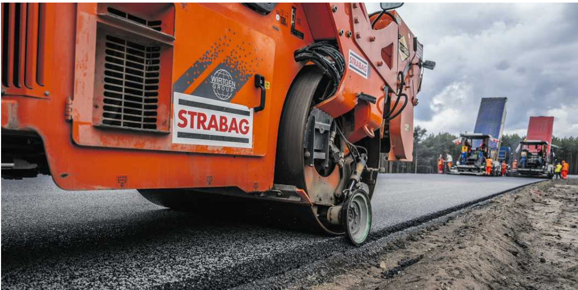
Na placach budowy w Polsce wprowadzane są ekologiczne rozwiązania.
