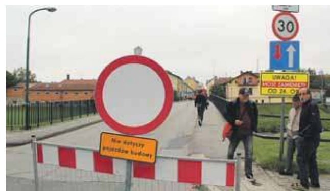
Remont mostu potrwa blisko trzy tygodnie.
