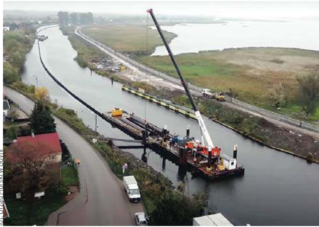
Pogrążanie grodzic na rzece Elbląg, brzeg zachodni
