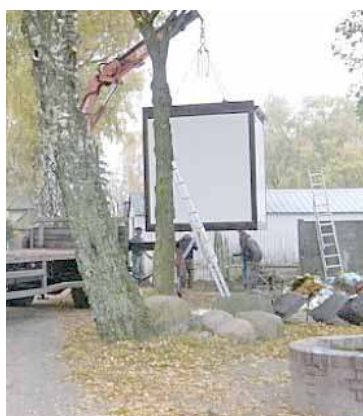
Toaleta kontenerowa została zainstalowana 7 lat temu. Fot. UM Nowogard
