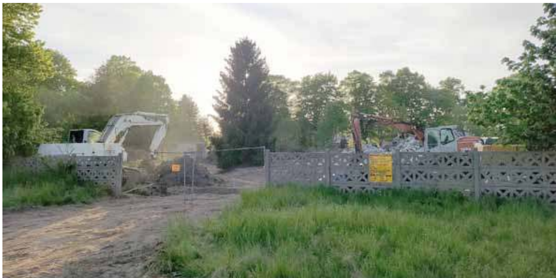
Na terenie budowy prace trwają od trzech tygodni
