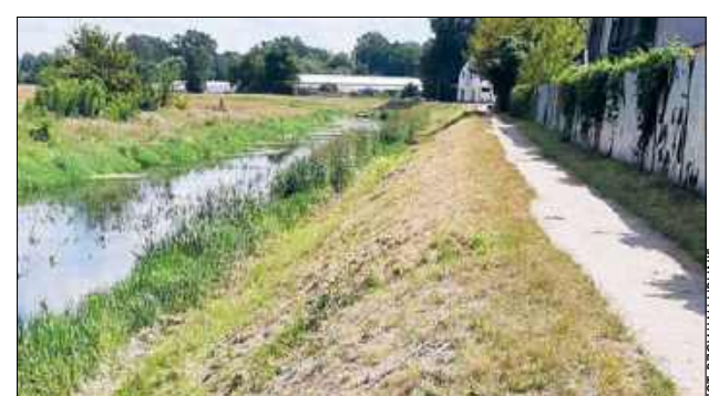
Przejście na wale przy Krzynie będzie wyłączony z użytkowania do 4 sierpnia
