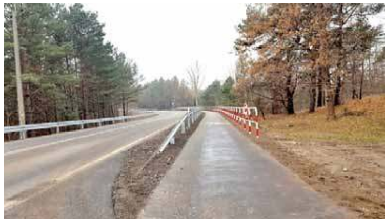
Droga wojewódzka nr 151 na odcinku Ińsko - Ciemnik
