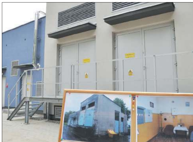
■ Obiekt stacji zasilającej przeszedł gruntowny remont
