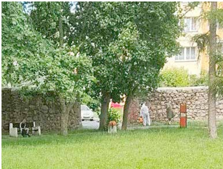
Prace konserwacyjne przy murach zostały rozpoczęte w ubiegłym tygodniu
