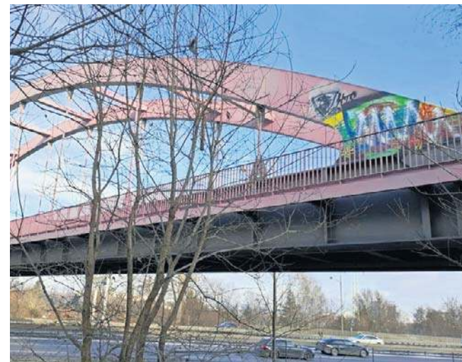
...natomiast z drugiej strony mostu już jest zamalowany
