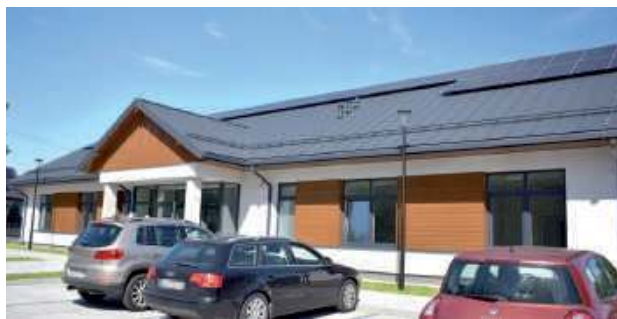
Nowy budynek jest już wyposażony w instalację fotowoltaiczną i parking na kilkanaście samochodów
