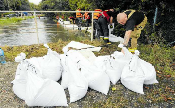
• Gdy potok wezbrał, strażacy układali worki z piaskiem oraz rękawy przeciwpowodziowe FOT. ROBERT KOWALEWSKI / AGENCJA WYBORCZA.PL
