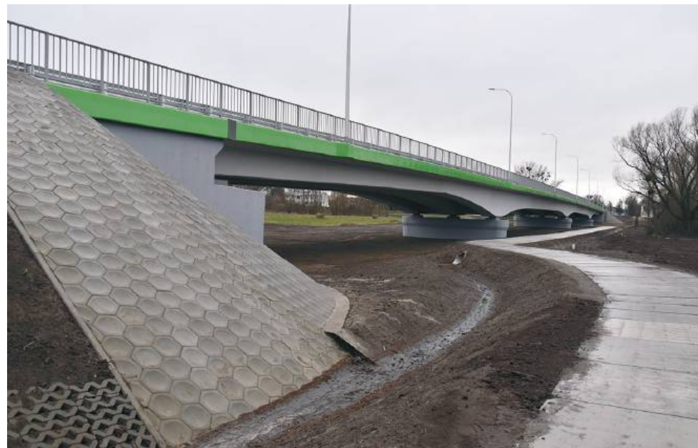
Budowa mostu przez rz. Wieprz w Trawnikiach
