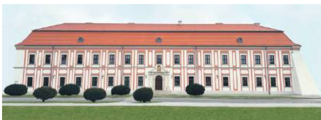
Uroczystość rozpocznie się 26 marca o godz. 10. Przewidziano część artystyczną oraz zwiedzanie budynku z przewodnikami.
