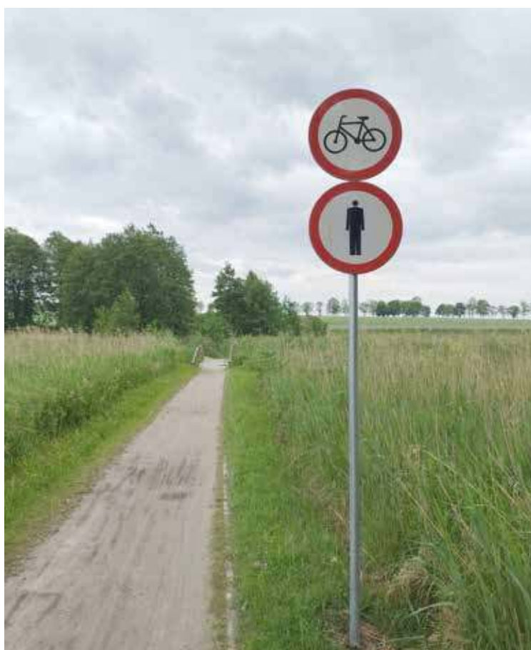
Tutaj nie zmieniło się nic. Mostek na ścieżce dookoła jeziora jest zamknięty od kilku miesięcy
