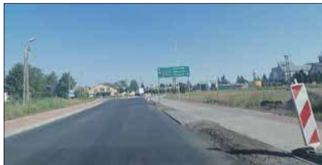
Niebawem ukończona zostanie przebudowa i rozbudowa drogi nr 1051L Zalesie – Piszczac – Sławatycze, a konkretnie odcinka od krajowej dwójki do granicy gminy Zalesie o długości prawie 2,5 km
