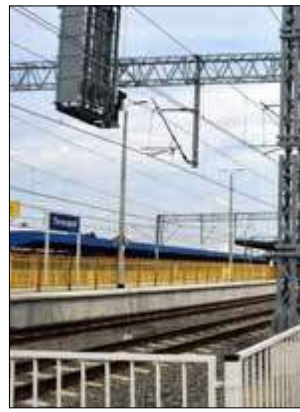
W ramach prac na linii kolejowej E20 Siedlce – Terespol, Polskie Linie Kolejowe modernizują m.in. stację Terespol
