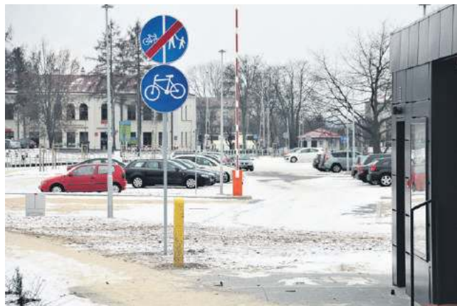
Nowy, przestronny parking obok wiat przystankowych.
