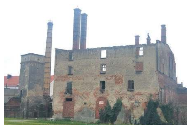
Tak wygląda budynek dawnego browaru z zewnątrz
