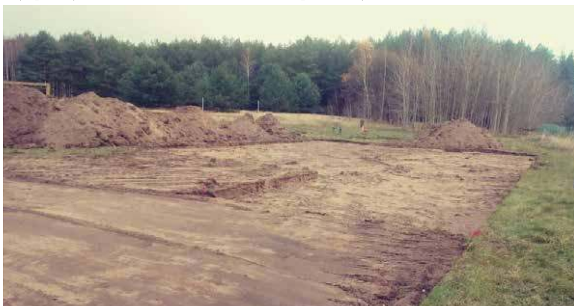
Inwestor rozpoczął przygotowywanie terenu pod budowę siłowni i placów zabaw, jednocześnie w 4 miejscowościach. Obiekty na wiosnę będą już służyły mieszkańcom
