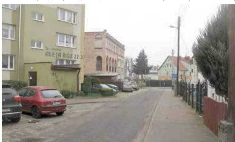
Na remont Alei Róż gmina w projekcie budżetu zaplanowała 2,6 mln zł
