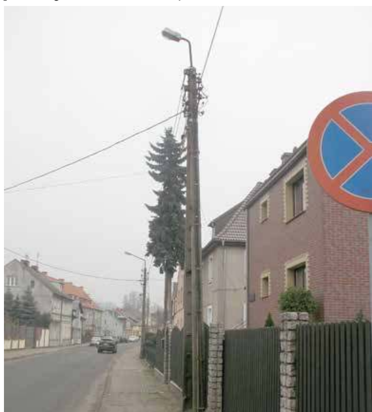
Pół miliona złotych ma wydać gmina na modernizację oświetlenia i instalację lamp tam, gdzie ich nie ma
