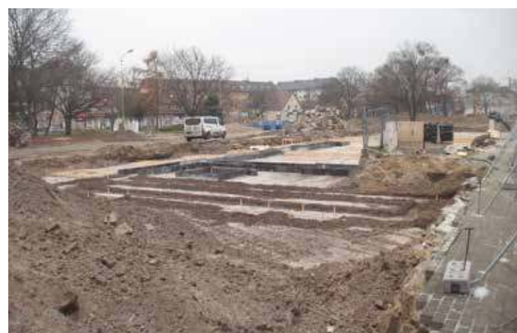
Budowa nowego dworca to najdroższa inwestycja w historii Goleniowa
