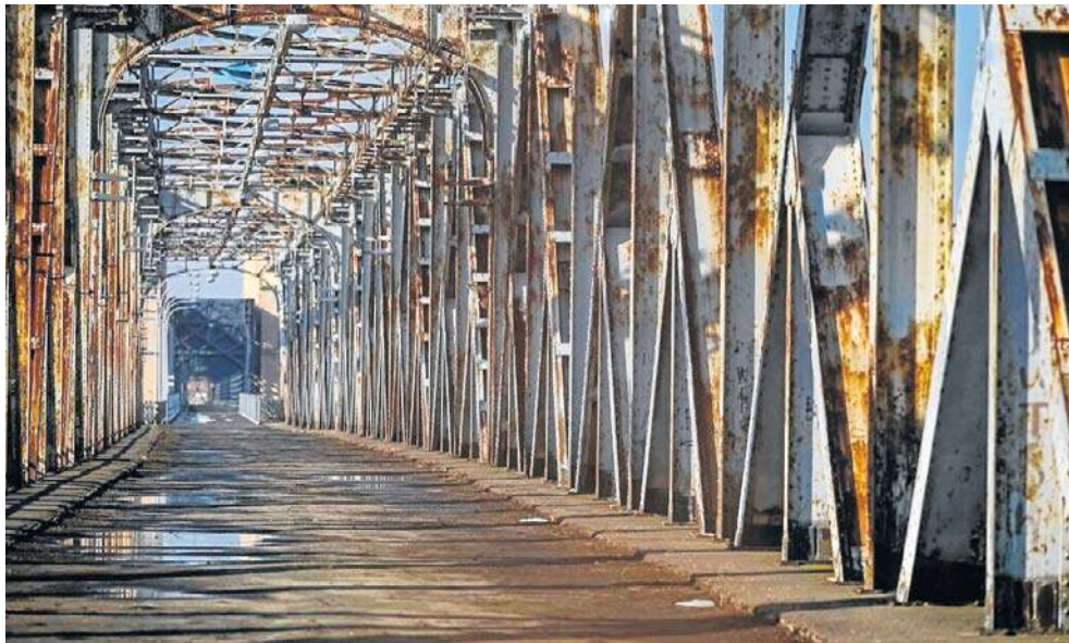
Most Tczewski od strony Lisewa Malborskiego
