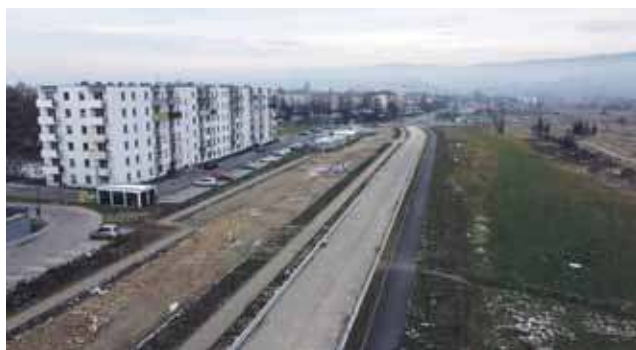
Brakujący fragment ul. Sikorskiego ma już nową nawierzchnię.
