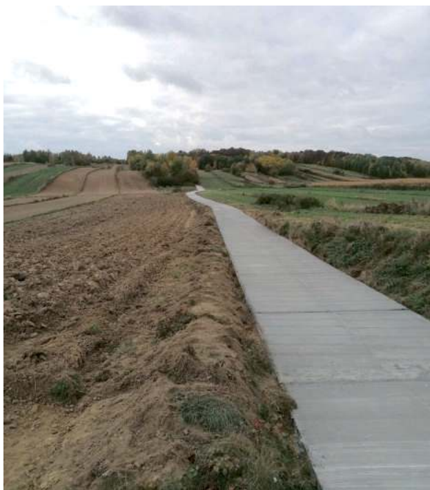
Pierwsze betonowe drogi, w gminie Turobin już są
