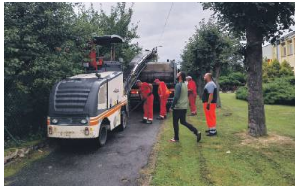
W czwartek, 1 sierpnia, rozpoczął się remont drogi prowadzącej do szkoły w Przewornie. Fot. UG Przeworno
