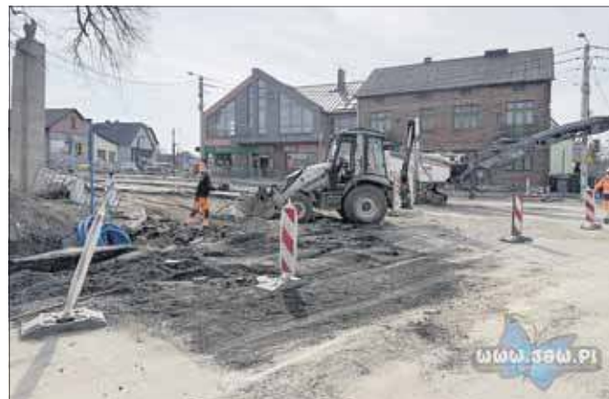
Przebudowa głównego skrzyżowania w Byczynie
