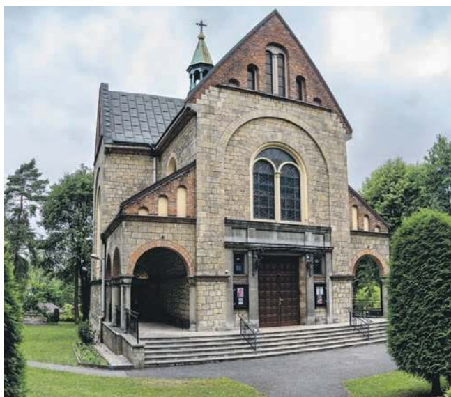
Widok na świątynię od strony głównej ulicy
