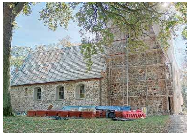
Kościół filialny w Sądowie obecnie przechodzi remont
