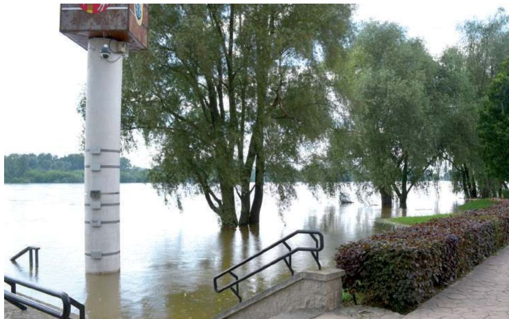
Choć woda w Wiśle przekroczyła stan alarmowy, nie spowodowało to większego zagrożenia. Dla porównania: widoczny na zdjęciu chodnik rok temu znalazł się pod wodą
