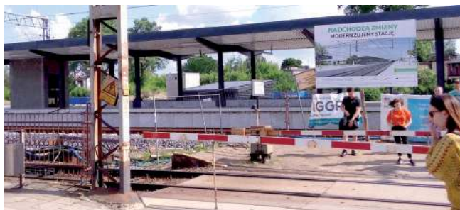
Pomiędzy szlabanami jest jeszcze stary tor, który wymaga demontażu. Za nimi widać nowy 400-metrowy peron wyspowy z olbrzymią wiatą. Za nim widnieje wejście do tunelu od strony ul. Dokudowskiej
