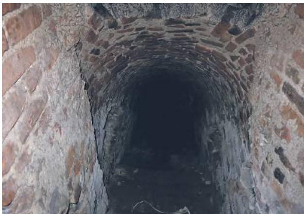
Klasztor bazylianów, zejście na drugi poziom piwnic pod częścią zachodnią budynku, 2022 r.
