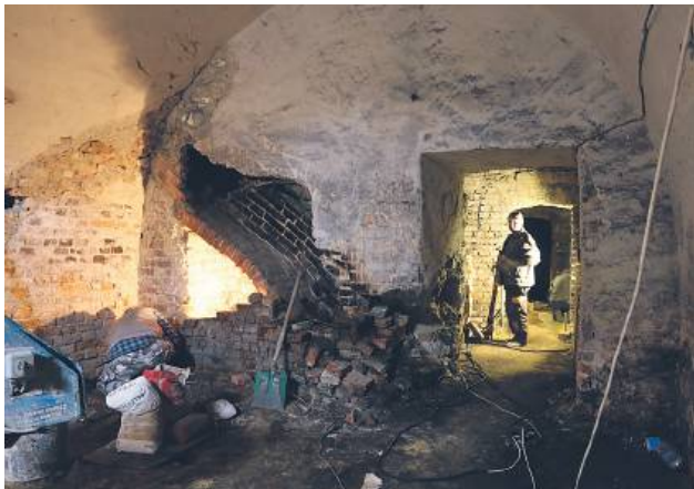
Klasztor bazylianów, piwnica w części wschodniej budynku, w głębi widoczny przewód kominowy, do którego był podłączony piec centralnego ogrzewania z początków XX w., 2022 r.
