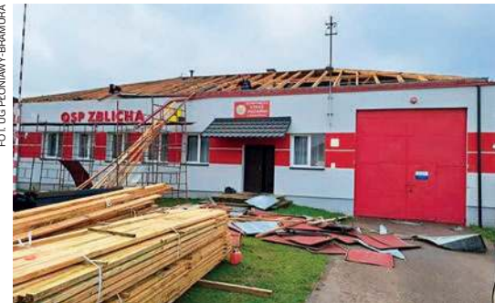
Trwa remont dachu na remizie w miejscowości Stara Zbli-cha.
