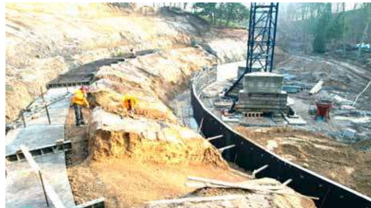
Po wykonaniu wszystkich robót ziemnych przyszedł czas na budowę elementów konstrukcyjnych widowni.
