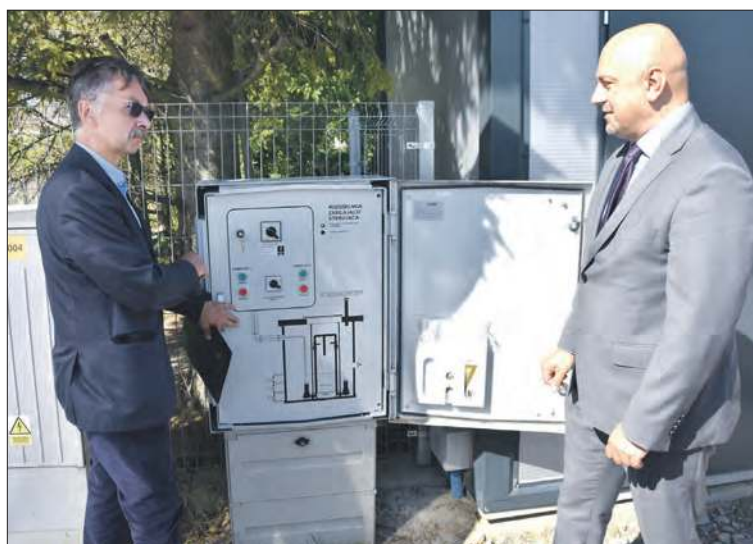
Kanalizacja Szybowic poprzez tranzyt do Niemysłowic połączona jest z prudnicką oczyszczalnią ścieków
