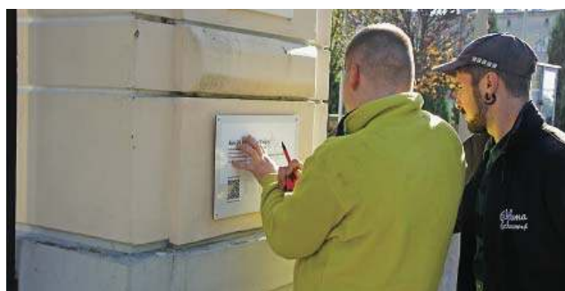
Montaż tabliczki na ogrodzeniu kościoła pw. Świętej Trójcy
