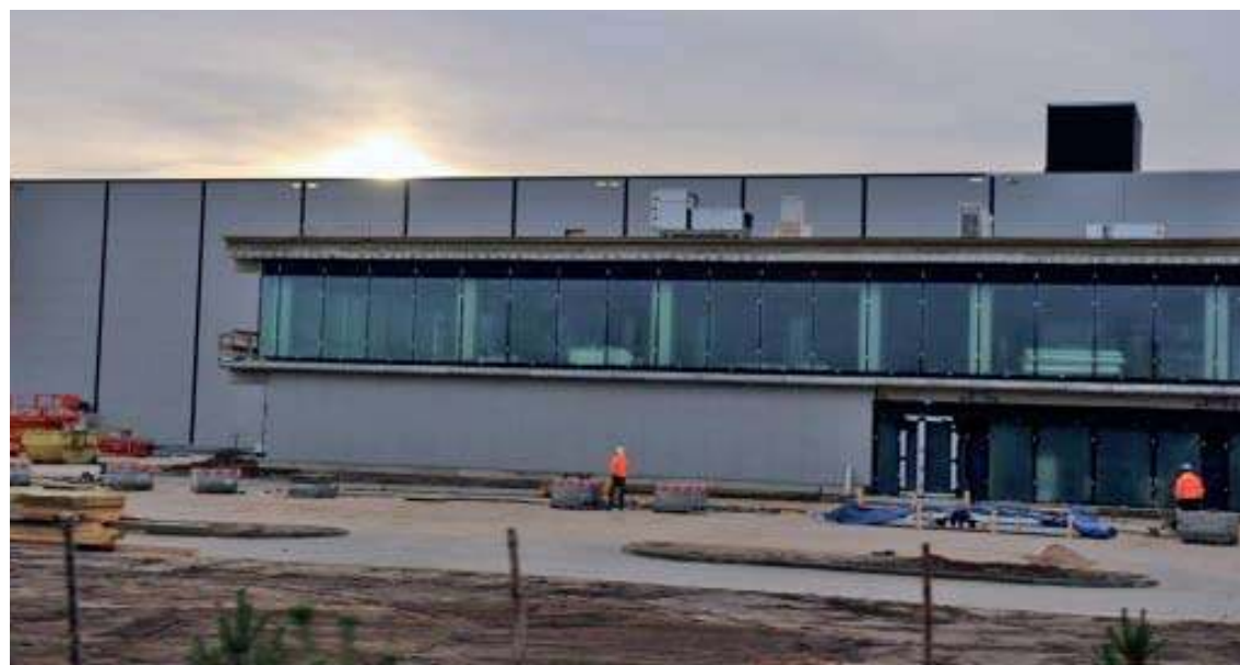
Budowa zakładu zbliża się do końca (fot. UM Nowa Sól)
