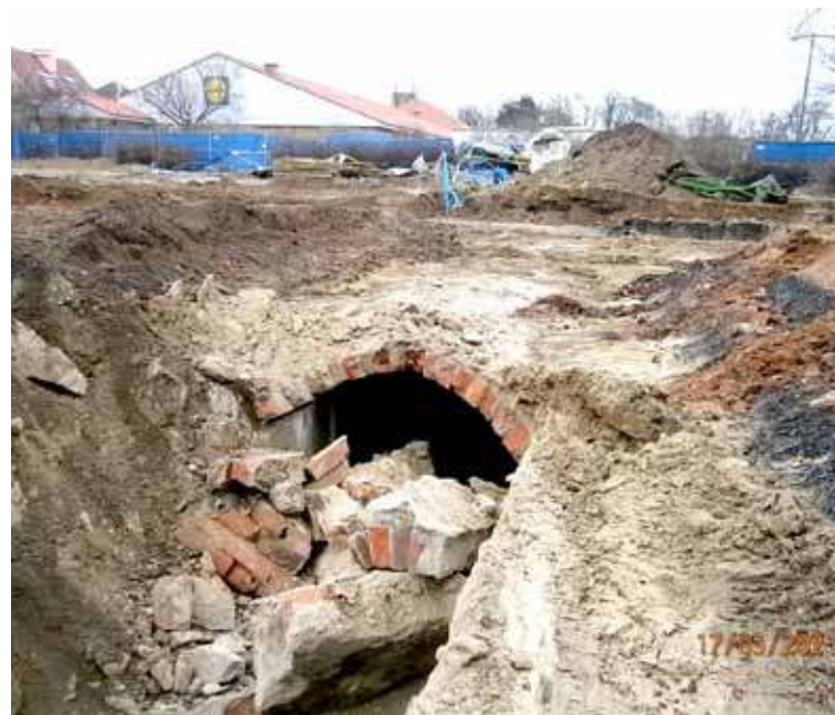
Wykonano prace związane z wyburzeniem i zasypaniem tunelu z czasów II wojny światowej
