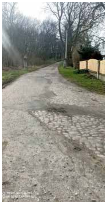
20 kwietnia rozpoczną się prace związane z przebudową drogi w miejscowości Kamienny Most.
