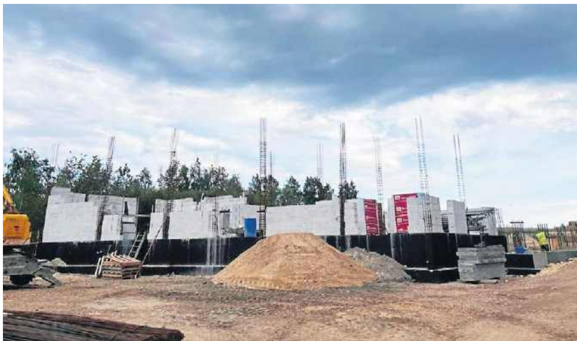
Firma GMP Service powstaje w Jędrzejowskiej Strefie Ekonomicznej - ruszyła budowa nowoczesnej hali.
