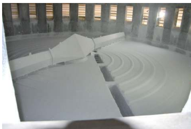
Jednym z urządzeń pracujących w wieży granulacyjnej jest tzw. zgarniak, który jak sama nazwa wskazuje rozgarnia lecący z góry nawóz
