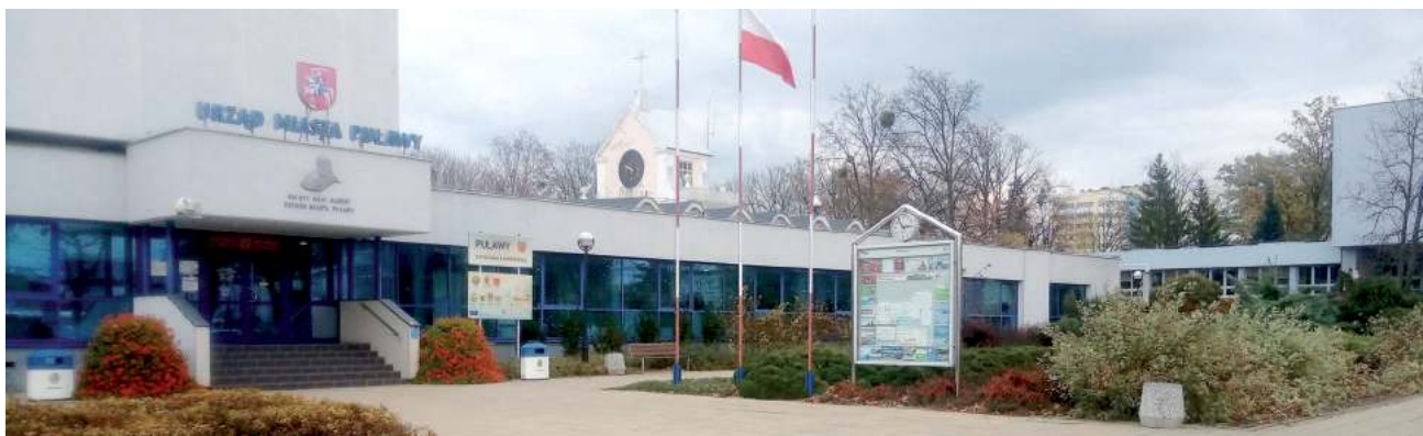
Jednym z większych projektów, który dzięki głosom mieszkańców zostanie zrealizowany w przyszłym roku będzie plac wypoczynkowy przed Urzędem Miasta Puławy. Ma być zlokalizowany po prawej stronie od wejścia głównego. Na tym terenie mają znaleźć się dwie długie ławki oraz drzewka dające zacienienie. Koszt inwestycji oszacowano na 300 tys. zł
