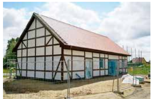
Budowa świetlicy w Maszkowie, gotowa ma być jesienią i to nawet wczesną
