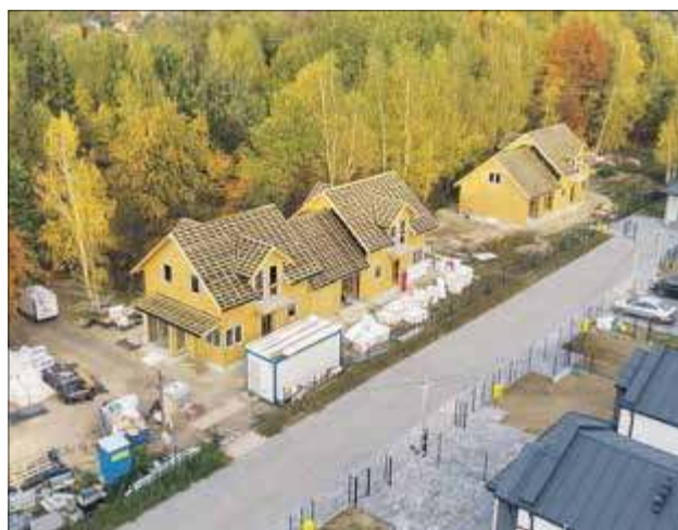
Greenline buduje domy z gotowych elementów, przygotowanych wcześniej na hali produkcyjnej
