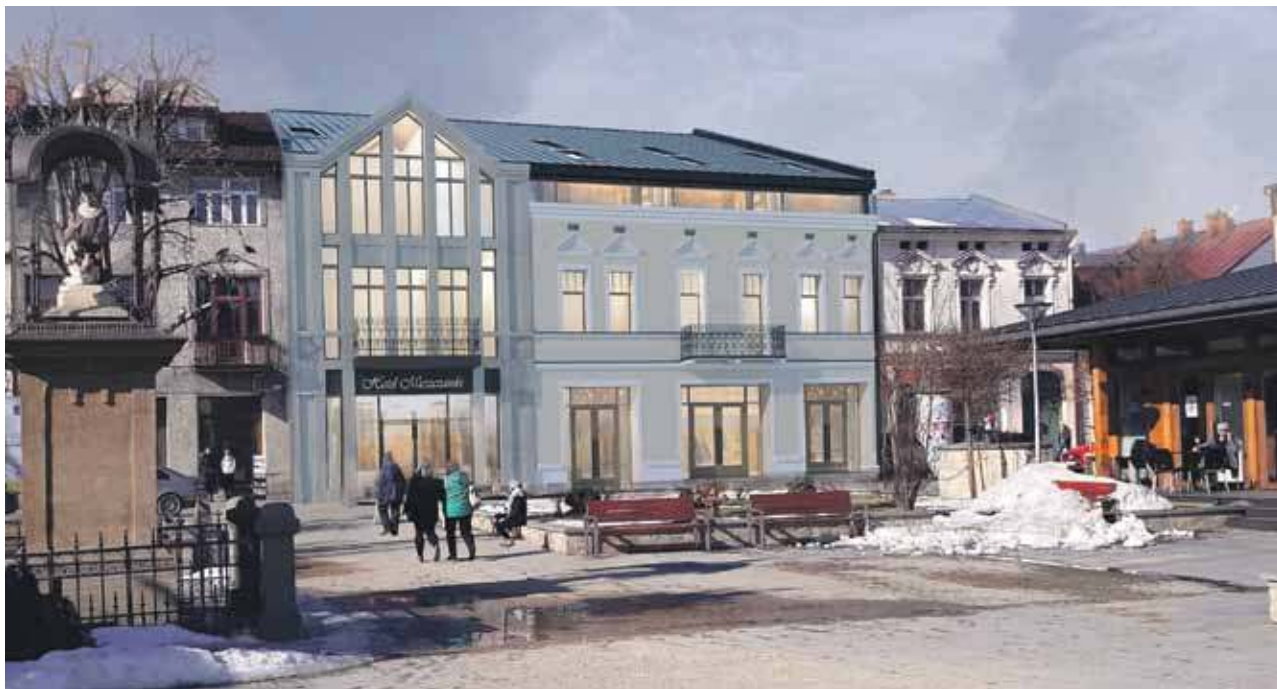
Z zewnątrz widoczne będą tak jak dotychczas dwie odrębne kamienice. Jednak wewnątrz wyrównane zostaną stropy i całość ma pełnić wspólne funkcje.
