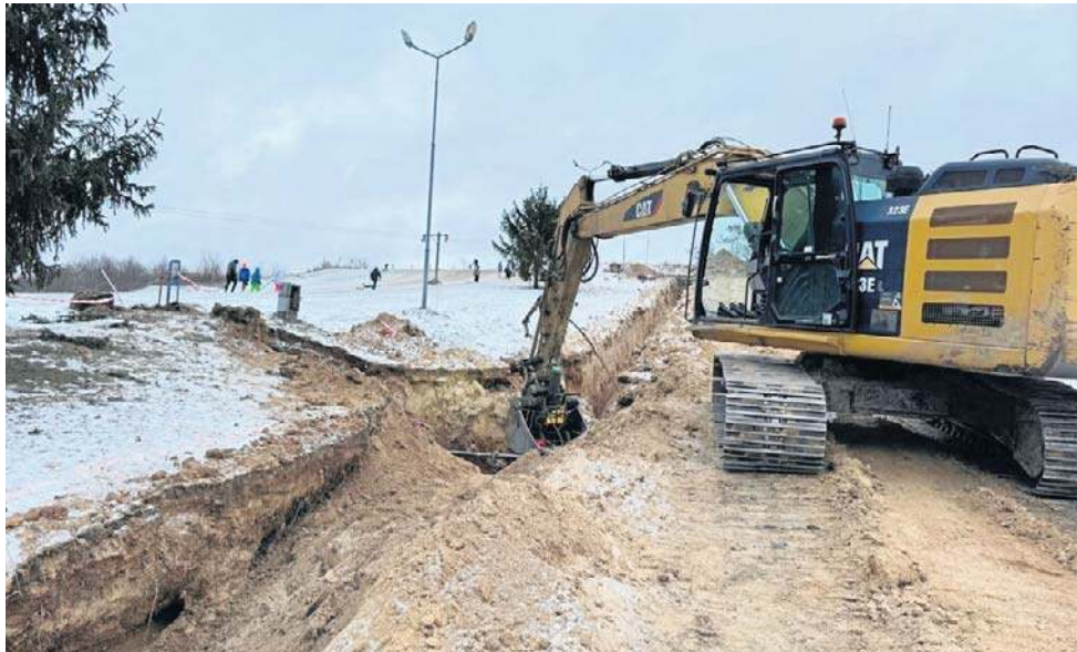
Niedziela, 11 stycznia. Ostatnie godziny prac przy wymianie rur na myślęcinskim stoku
